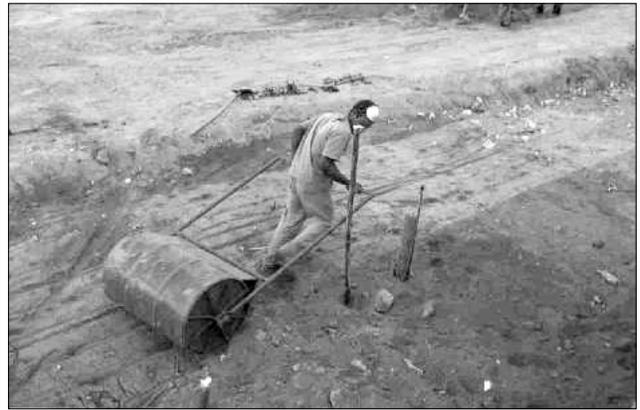
**Figura 8** Compactação da cobertura final com o rolo compactador manual.
