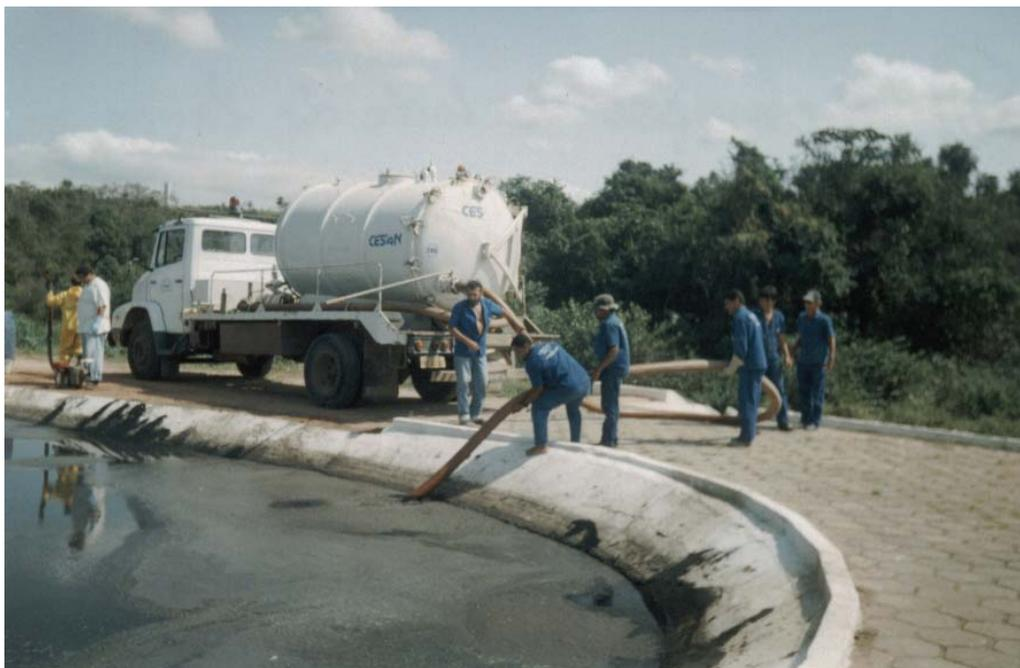
Figura 5.2 – Remoção de lodo de lagoa anaeróbia através de caminhão limpa-fossa (Cortesia: CESAN)
