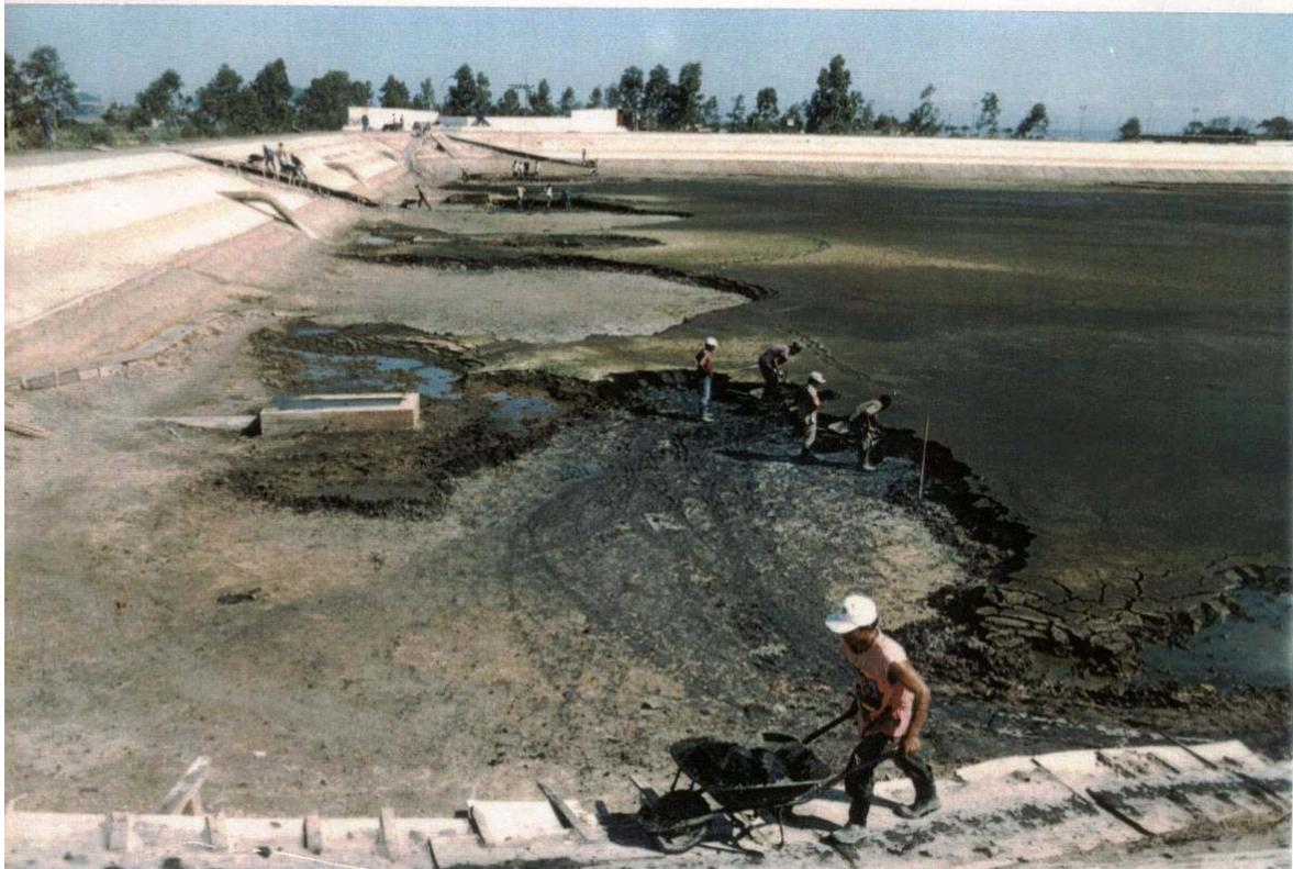
Figura 5.1 – Remoção manual do lodo de lagoa anaeróbia - Vitória (ES) (Cortesia: CESAN)
