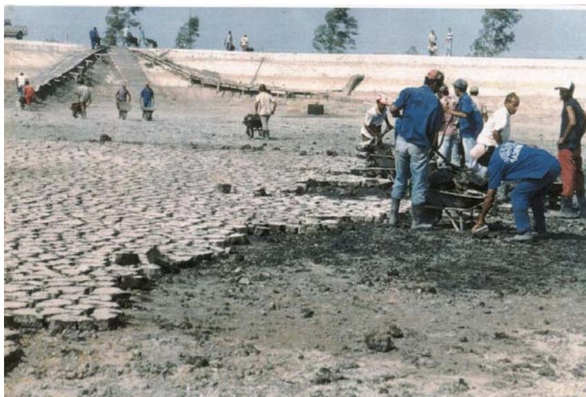
Figura 6.1 - Remoção do lodo seco ao ar livre na lagoa anaeróbia da ETE Camburi, Vitória (ES)
